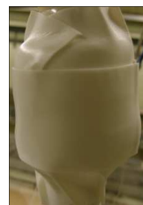
写真11. ドレン配管側ソケット状況
