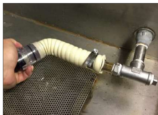
写真2. 気密曲げ試験状況(ホース部)
